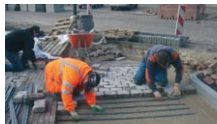
Stap 1a: De geleidingslatten ten minste 3 tot 5 rijen vooruit plaatsen...
