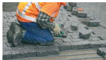
Stap 2a: Positioneren van stenen op de geleidingslatten...
