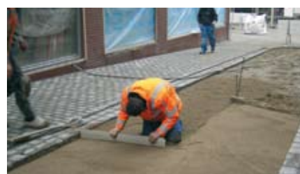
Vorbereiden van het zandbed.
