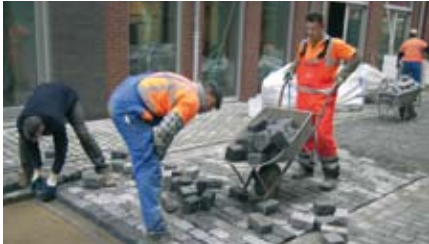
Stap 2d: Aanbrengen van materialen via de nieuwe bestrating.
