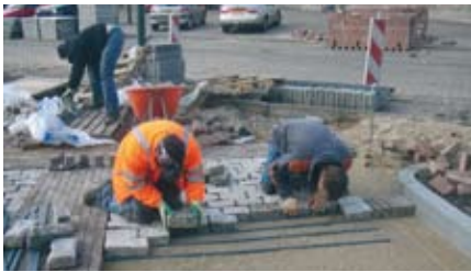
Stap 2c: ... en direct van op de nieuw aangelegde bestrating.
