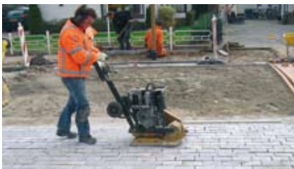
Stap 3b: ... en tot slot aftrillen.
