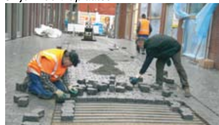
Stap 1b: ... en fixeren met stenen.
