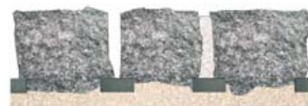
Aangepaste stenen worden op de EKOL-geleidingslatten geplaatst.
